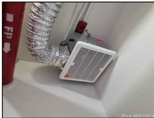
รูปที่ 26 เครื่องดูดอากาศภายในห้องพักมูลฝอยเปียก
