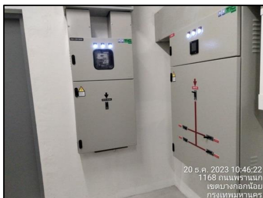
รูปที่ 35 ห้องเครื่องไฟฟ้าหลัก (Main Distribution Board : MDB)
