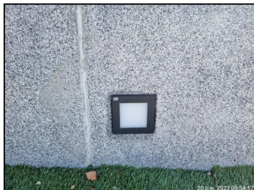
รูปที่ 60 ไฟฟ้าส่องสว่างบริเวณพื้นที่หนีไฟทางอากาศ
