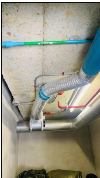
รูปที่ 26 เครื่องดูดอากาศภายในห้องพักมูลฝอยเปียก
