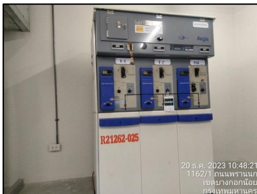
รูปที่ 34 ห้องเครื่องวัดหน่วยไฟฟ้าแรงสูงของการไฟฟ้า (Ring Main Unit : RMU)
