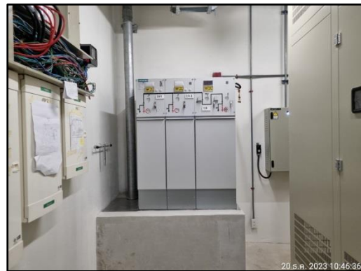
รูปที่ 35 ห้องเครื่องไฟฟ้าหลัก (Main Distribution Board : MDB)
