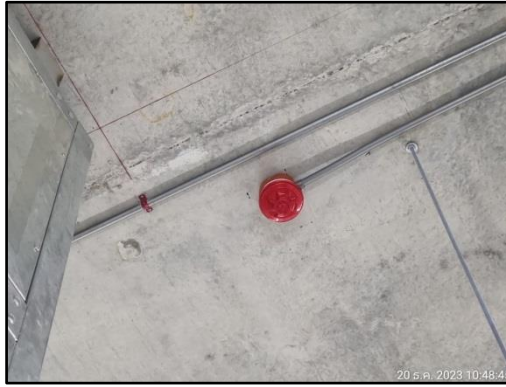
รูปที่ 51 เครื่องตรวจจับควันภายในห้องไฟฟ้า
