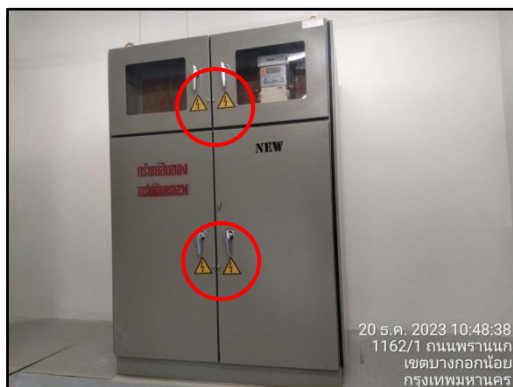
รูปที่ 40 ป้ายเตือนอันตรายไฟฟ้าแรงสูง บริเวณห้องหม้อแปลงไฟฟ้า
