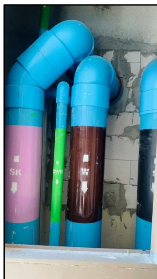
รูปที่ 27 ท่อรวบรวมน้ำจากห้องพักมูลฝอย
