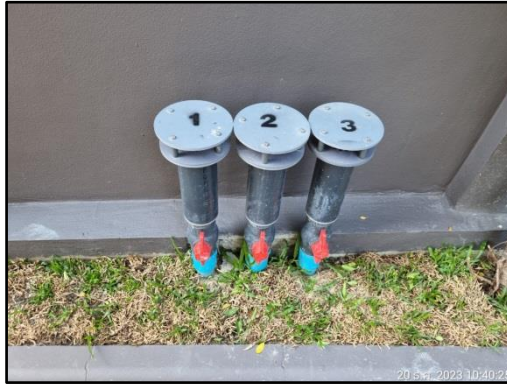
รูปที่ 72 ท่อระบาย Aerosol
